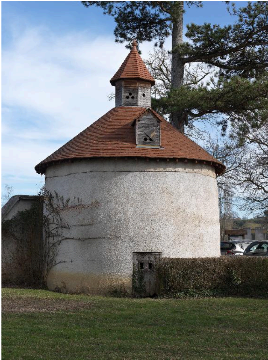
Pigeonnier, depuis le sud-est
