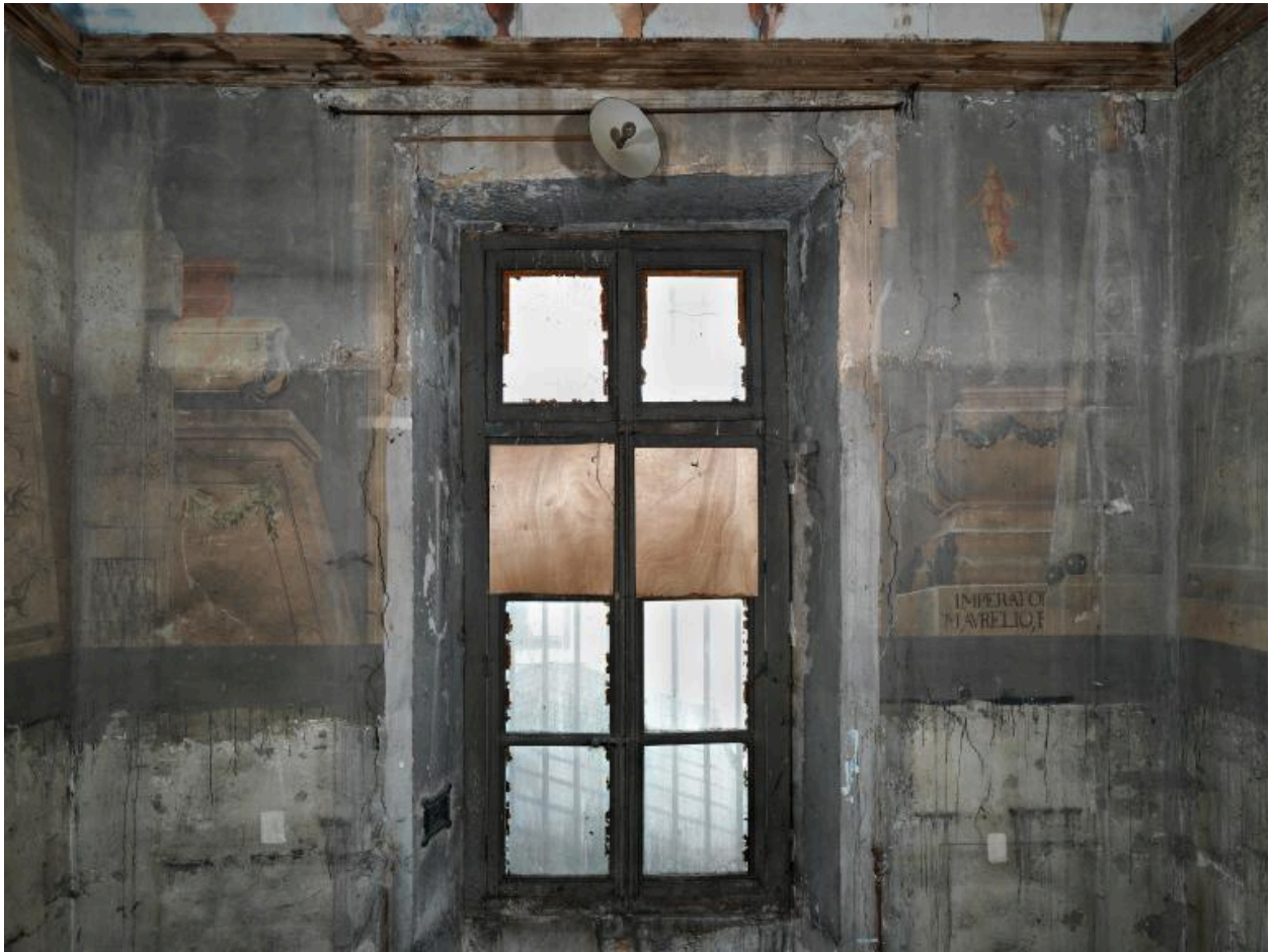
Mur sud : vue d'ensemble après dépose des boiseries, sept. 2018
