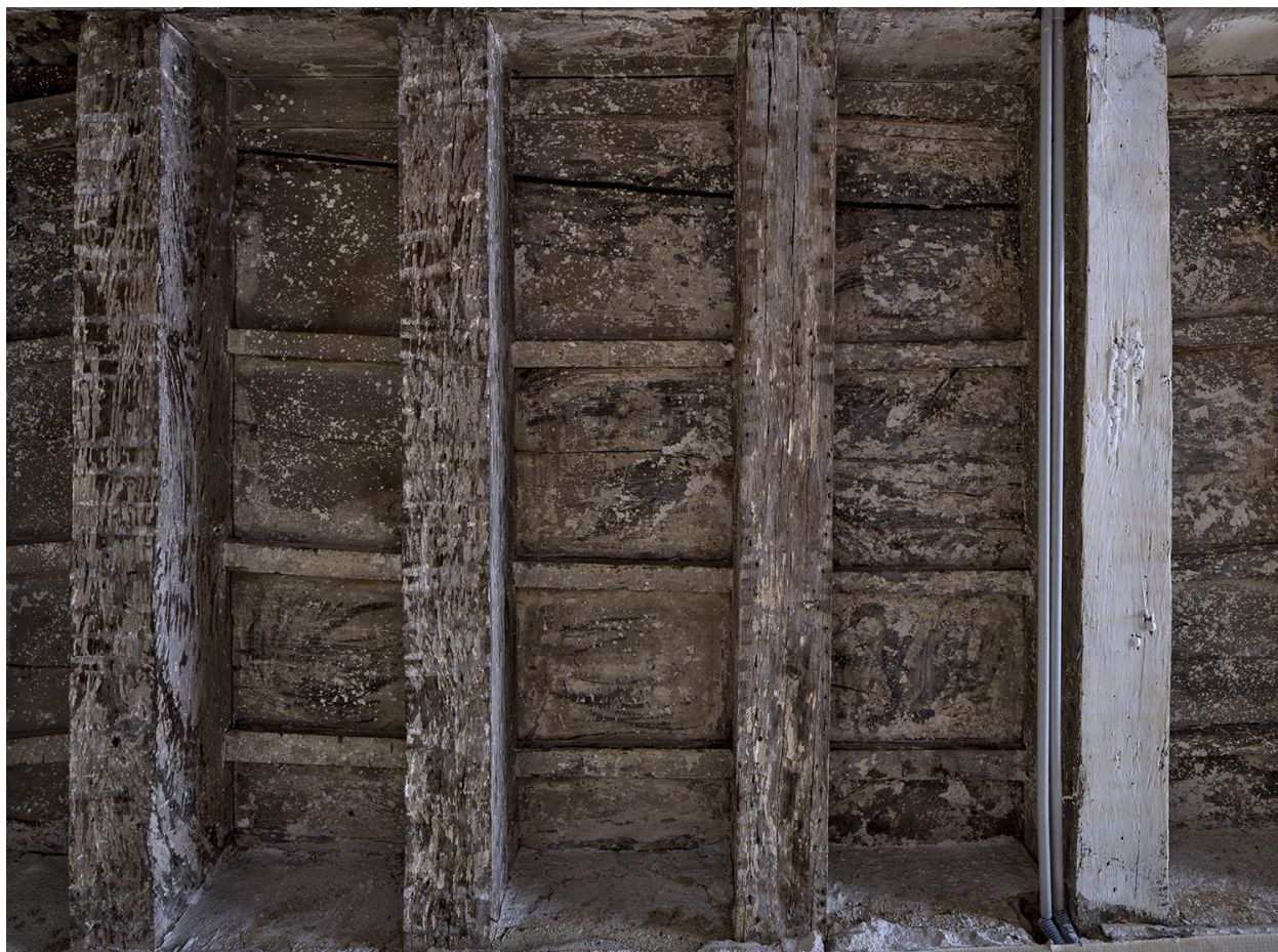
Rez-de-chaussée de la maison, détail d'un angle du plafond de la cuisine du rez-de-chaussée, plafond avec couvres-joints en bois.
