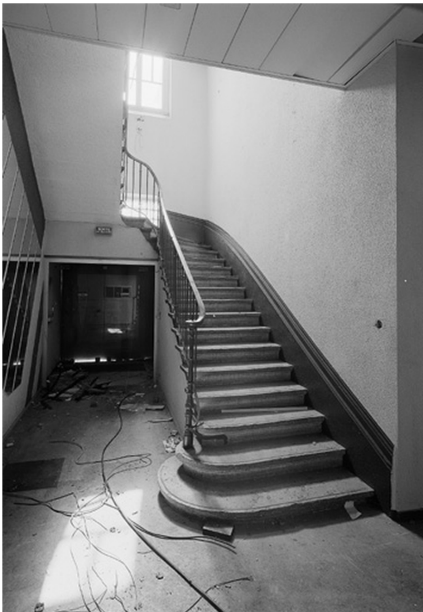
Escalier intérieur, aile gauche
