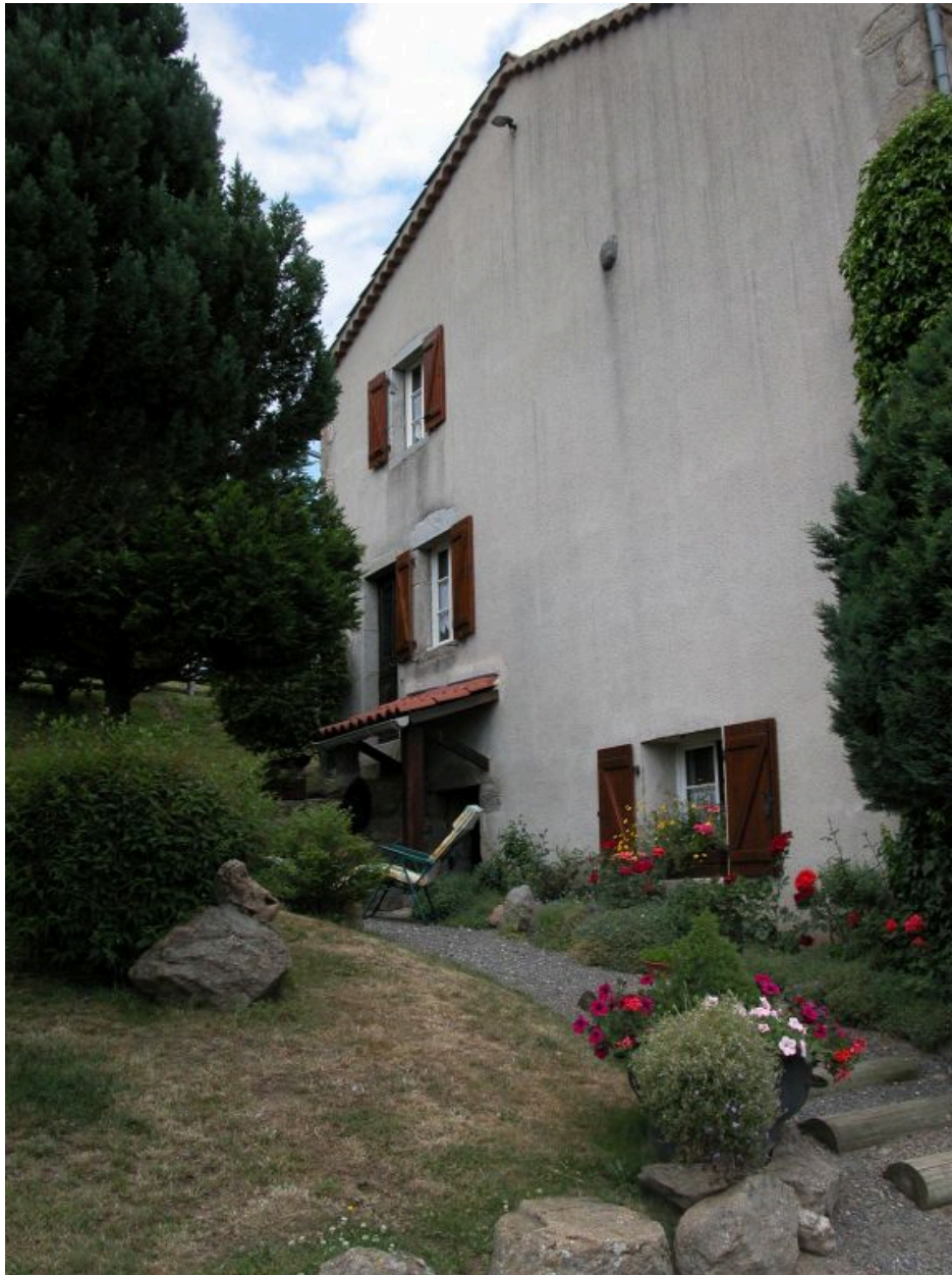
Vue d'ensemble du mur pignon sud de la ferme avec les ouvertures du logis arrière.
