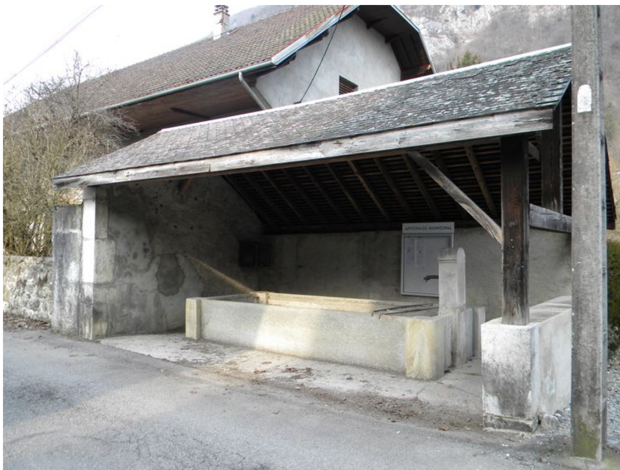
Vue générale du bassin et de sa couverture
