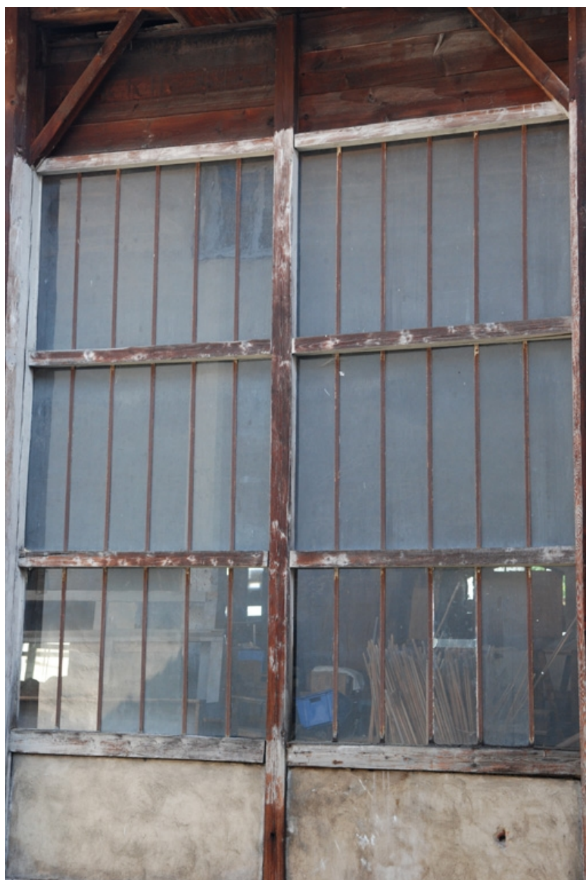
Détail verrière atelier menuiserie
