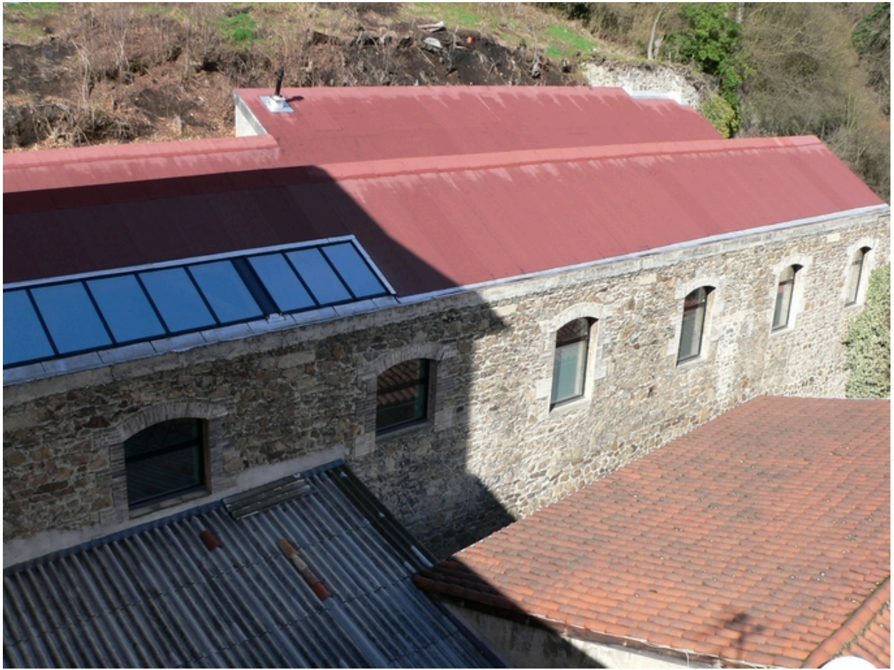
Bâtiment à Sheds
