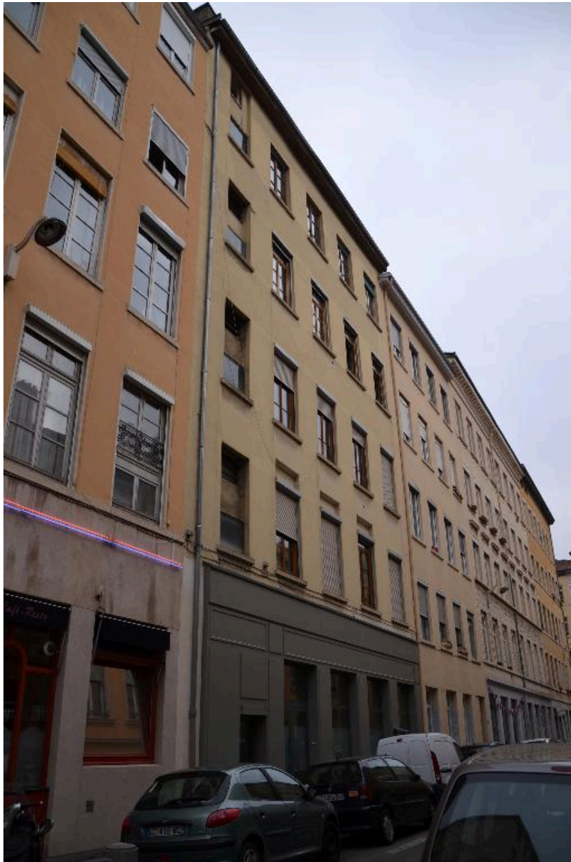
Vue d'ensemble façade sud
