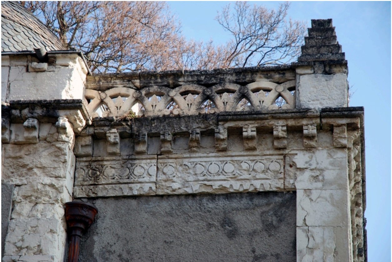
Elévation latérale ouest, détail de la corniche
