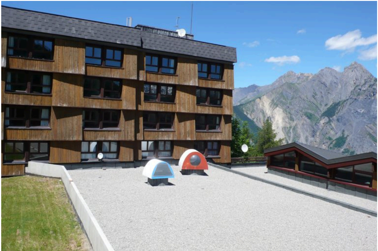
Toit du bâtiment et sculpture Les Yeux de Véra Szekely
