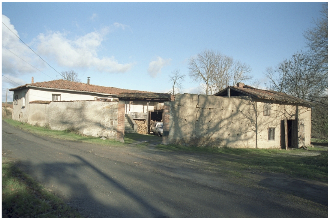
Saint-Sixte, Jay (1987 A2 427), type A1. Vue d'ensemble de la ferme depuis l'extérieur.
