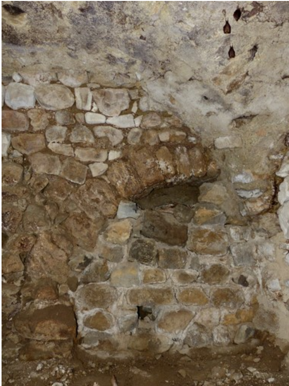
Dépendance sud-ouest. Etage de soubassement, cellier. Angle nord-est, ouverture murée (ancien canal de fuite?).
