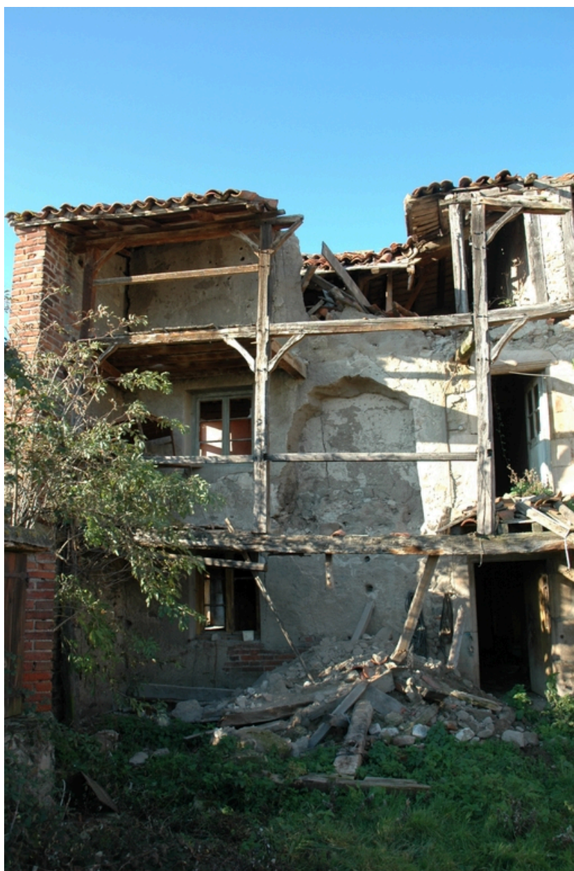
Vue de la partie sud de la façade principale du logis, depuis l'est (état en 2006).
