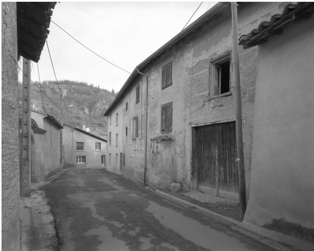
Vue d'ensemble depuis la rue, au sud-ouest.
