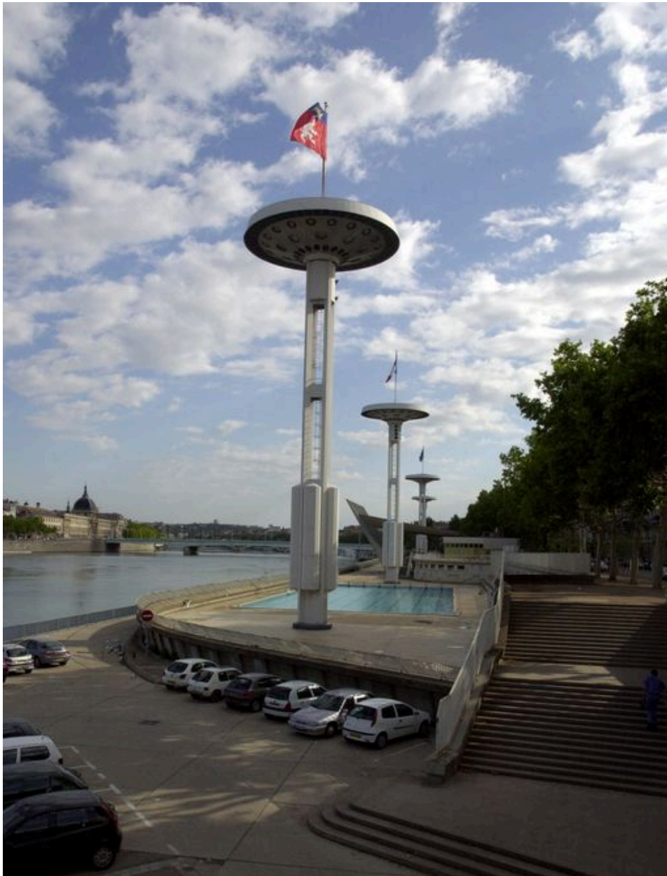
Vue générale depuis le sud, l'alignement des mâts d'éclairage le long du Rhône
