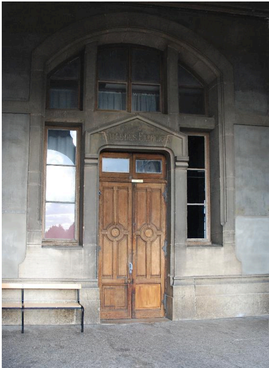
Cour, galerie nord-ouest, détail d'une porte encadrée d'une baie vitrée
