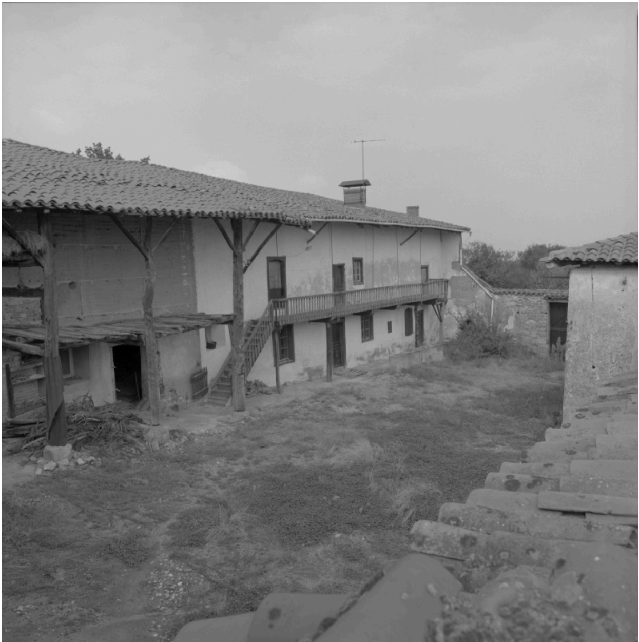
Bussy-Albieux, Albieux (1987 A2 866), type A1. Ferme à galerie, vue intérieure de la cour, façade du logis avec galerie.
