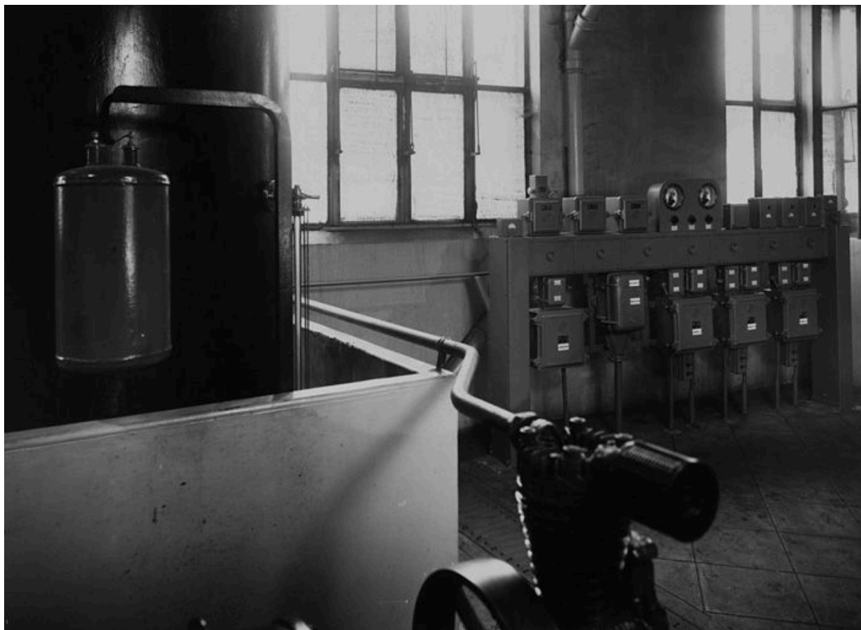
Equipement technique. Photogr., 1958 ?
