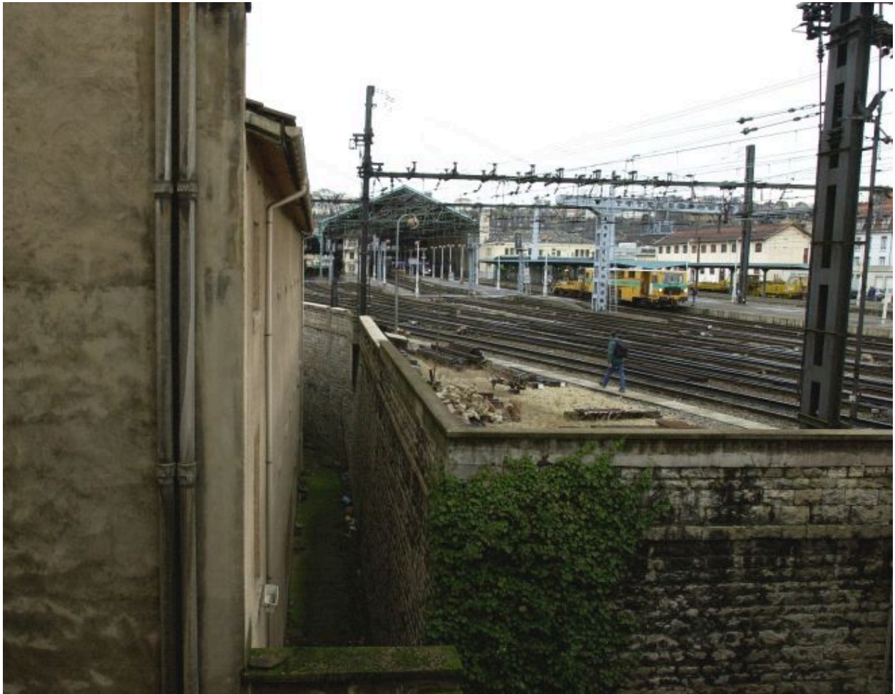
Vue de la ruelle longeant la gare au sud, depuis l'est
