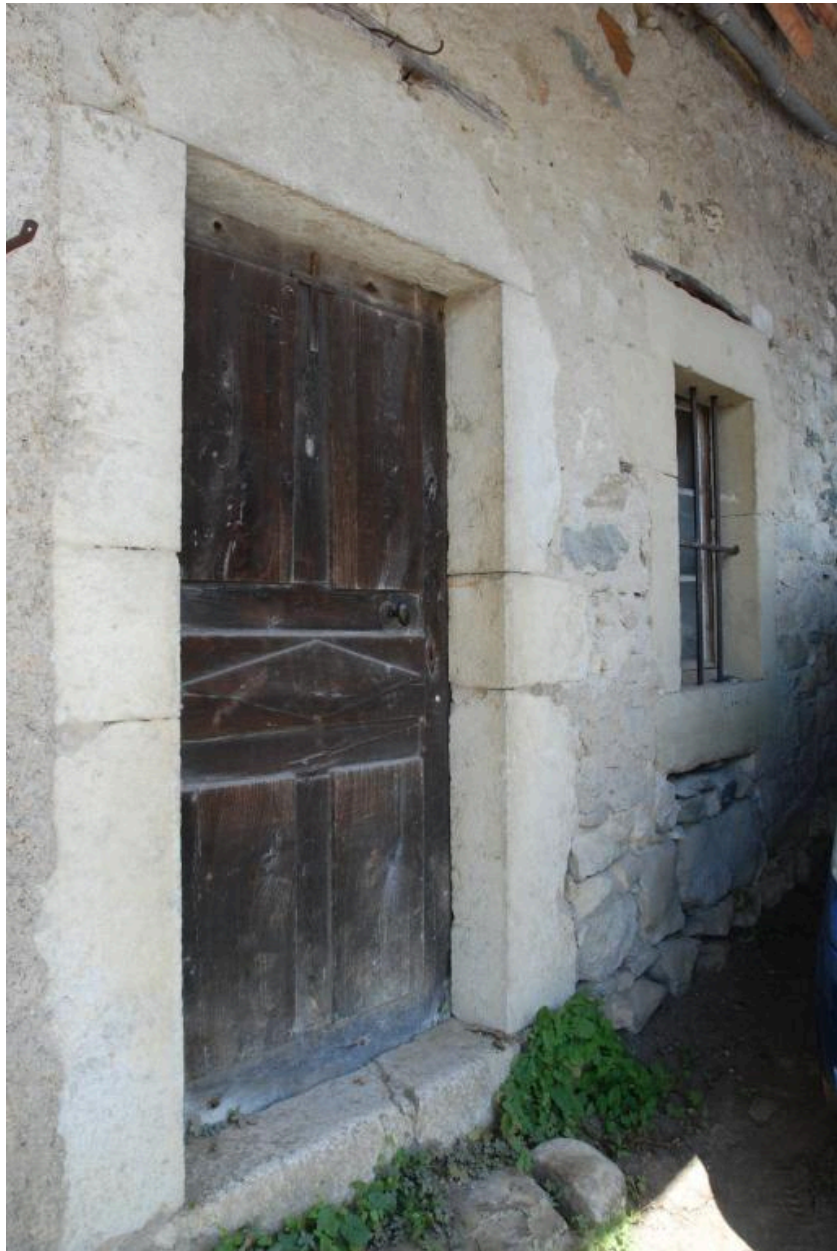
Détail des ouvertures de l'habitation est.
