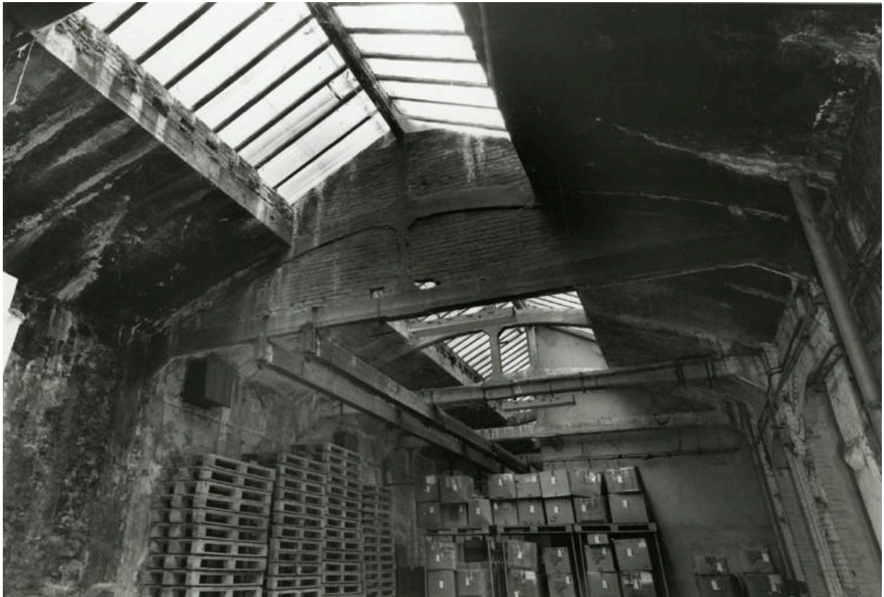
Détail charpente béton usine Vaganay-Proplan
