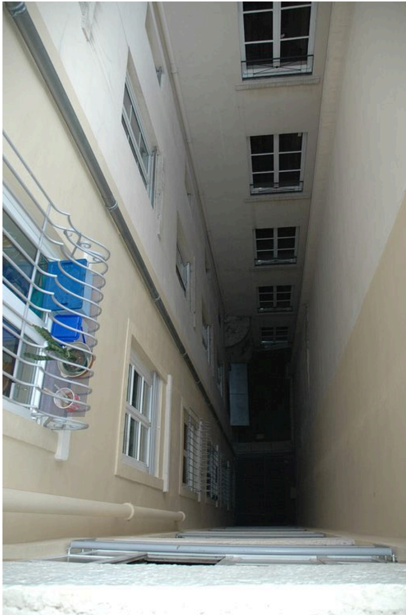
La cour depuis l'escalier 35 rue de Brest
