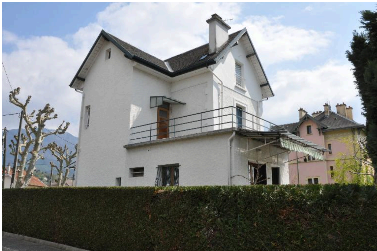
Vue depuis l'arrière
