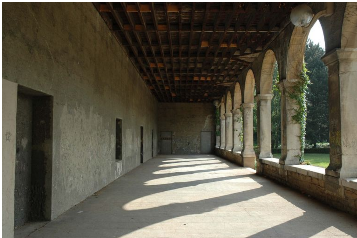
Bâtiment de la galerie, vue du portique depuis le sud-ouest
