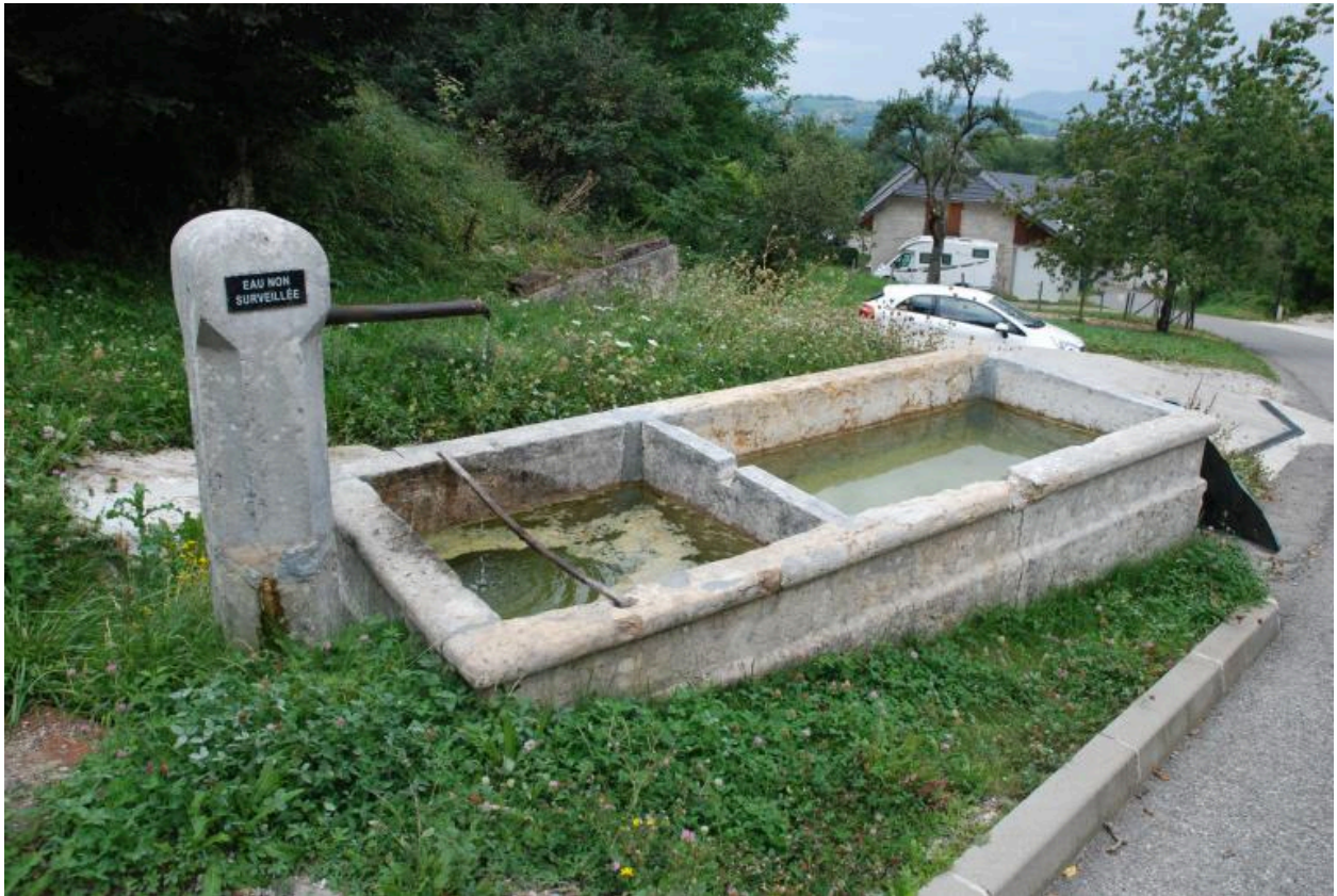
2015 C8 NC (vers 652), bassin. Vue d'ensemble.
