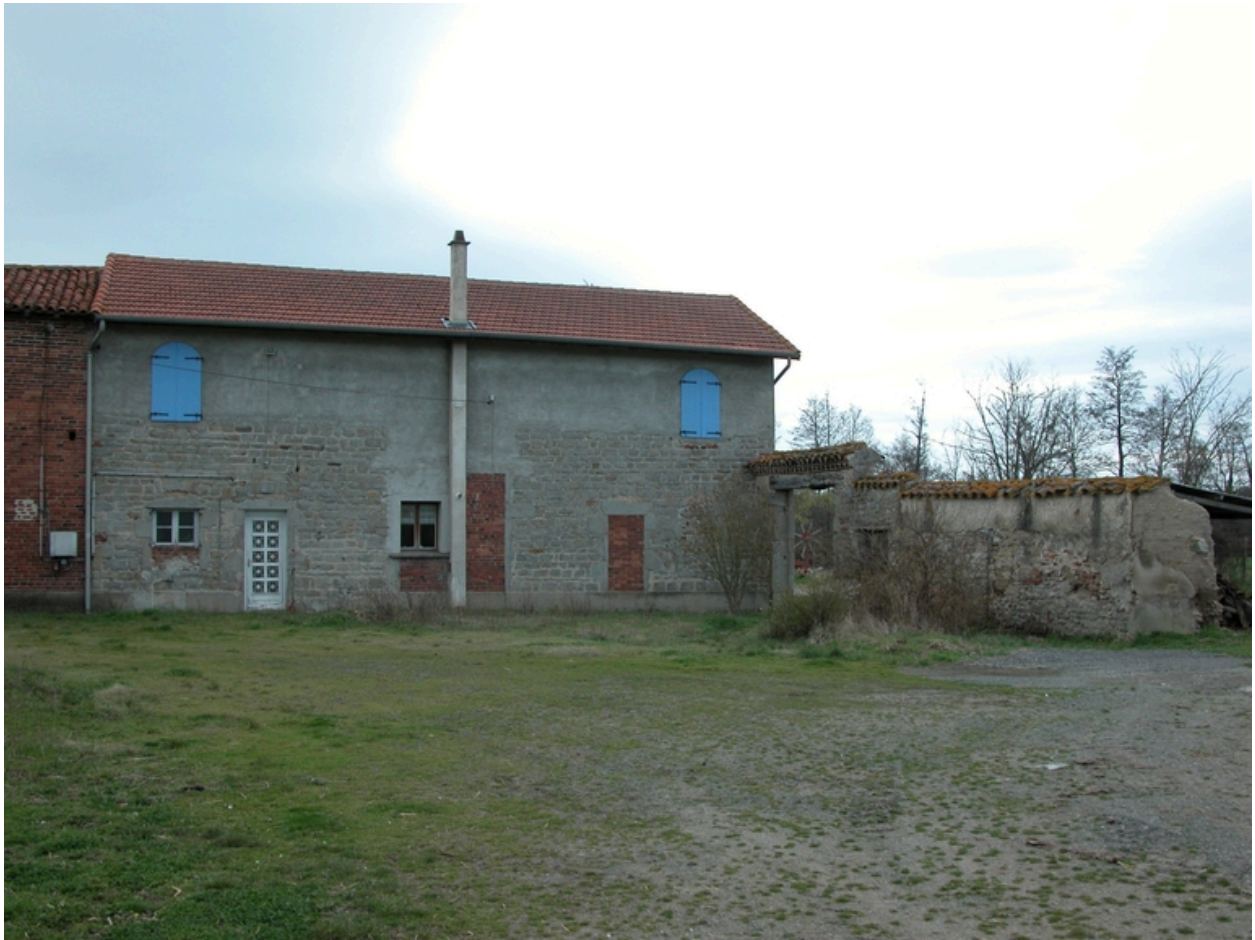
Vue d'ensemble de l'élévation nord du logis 2.
