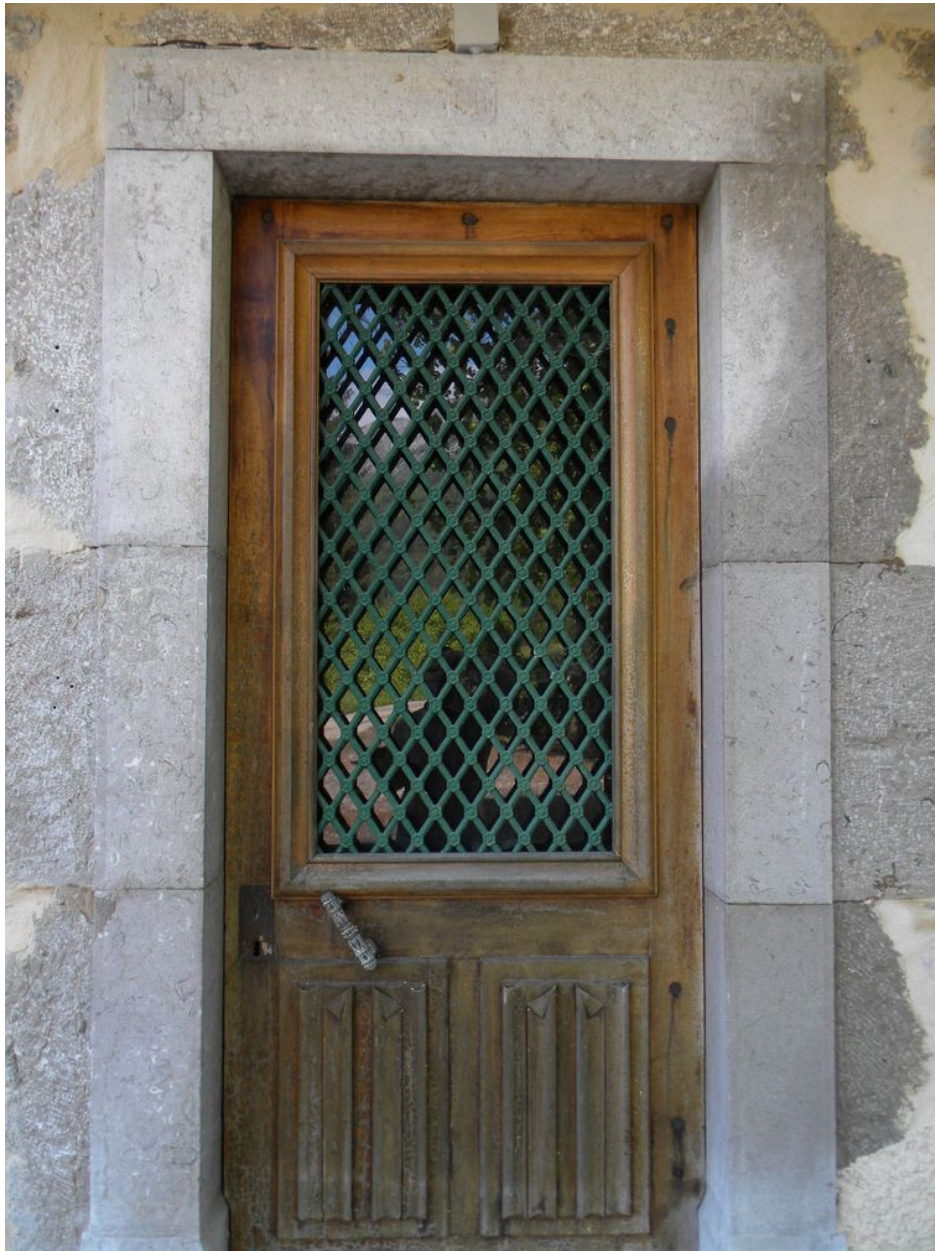
Encadrement de porte sur la façade nord.
