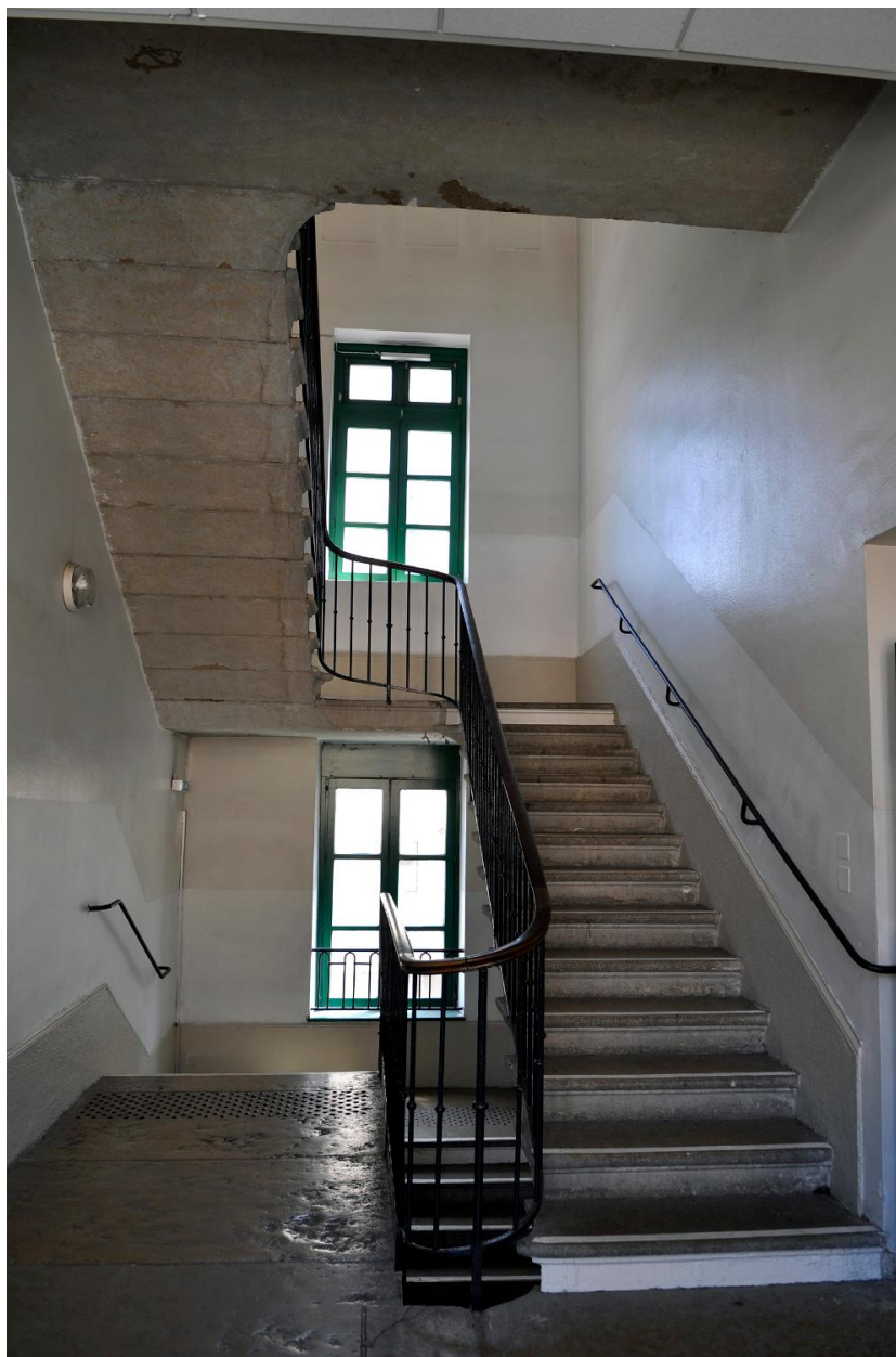
Bâtiment E : escalier de l'EPCI au niveau du 1er étage (actuel escalier E)
