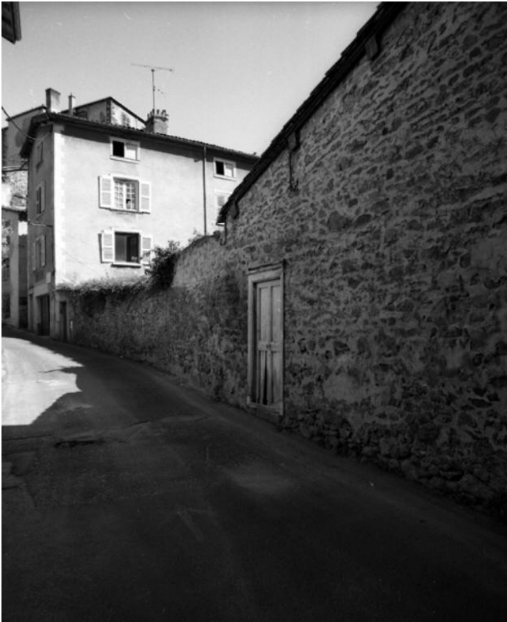
Mur de clôture sur rue et élévation sud de la maison, avant les travaux de reconstruction et d'agrandissement de 2011.
