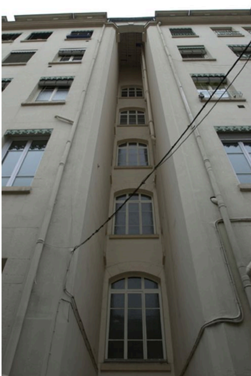
Cage d'escalier, vue extérieure vers le haut
