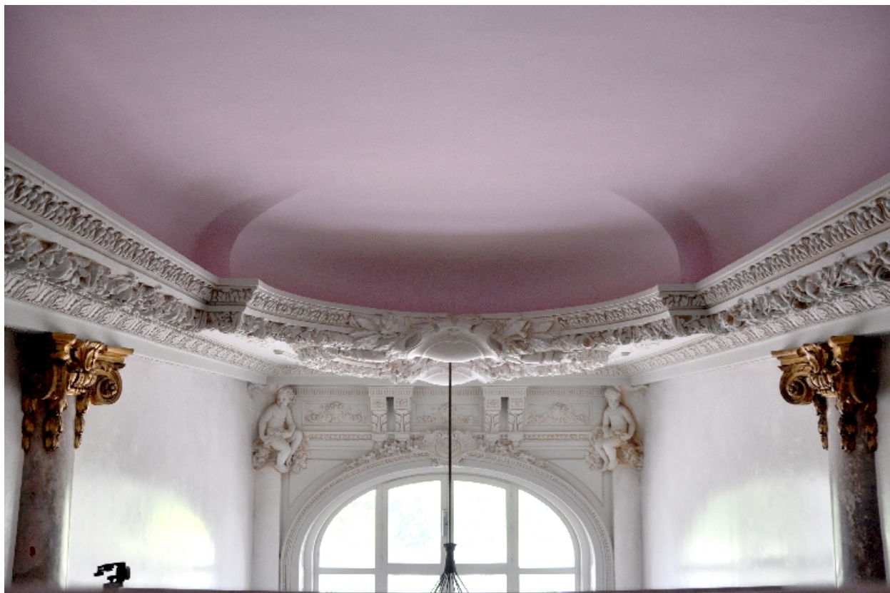
Plafond de l'ancienne salle à manger
