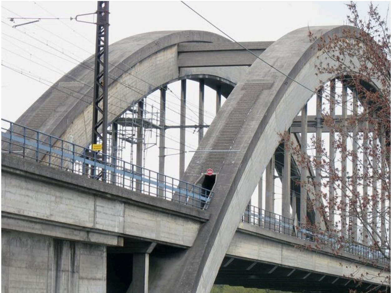
Vue latérale de l'arc, partie supérieure, face amont (depuis la rive gauche)
