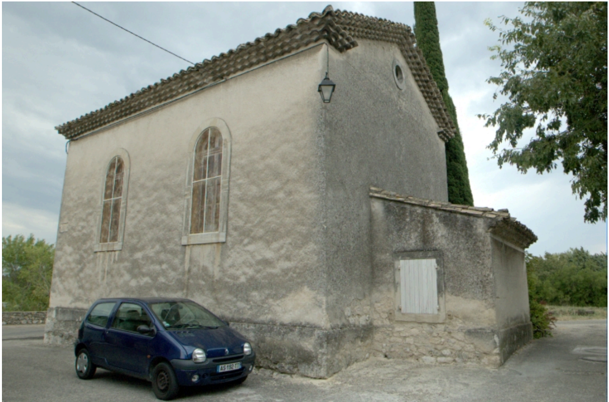
Elévation latérale droite et mur pignon auquel est adossée la sacristie.
