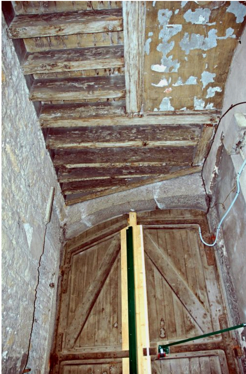
Détail du plafond du passage couvert depuis le nord
