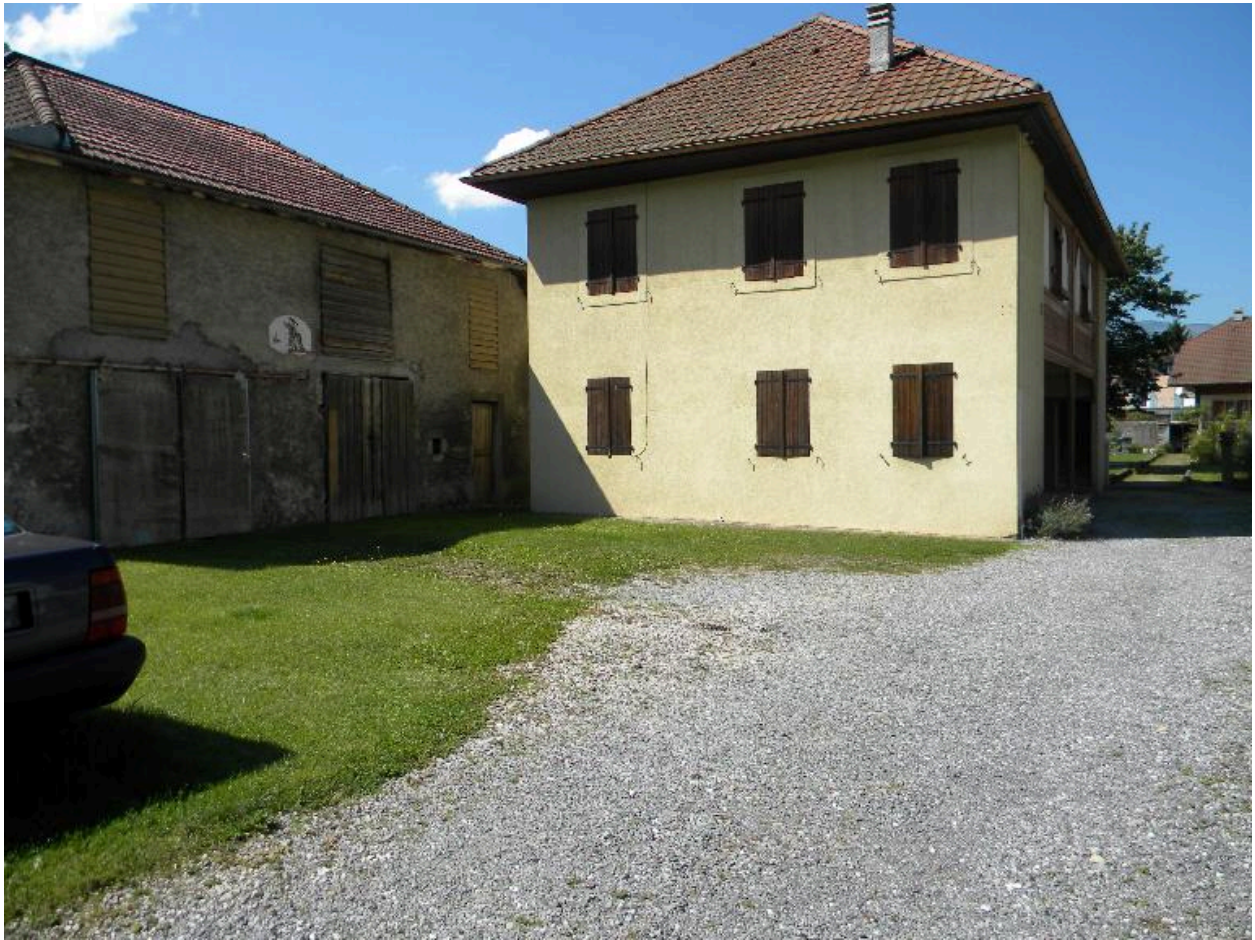
Vue d'une maison sur cour avec un bâtiment agricole à l'arrière plan (2008 D15 5378).
