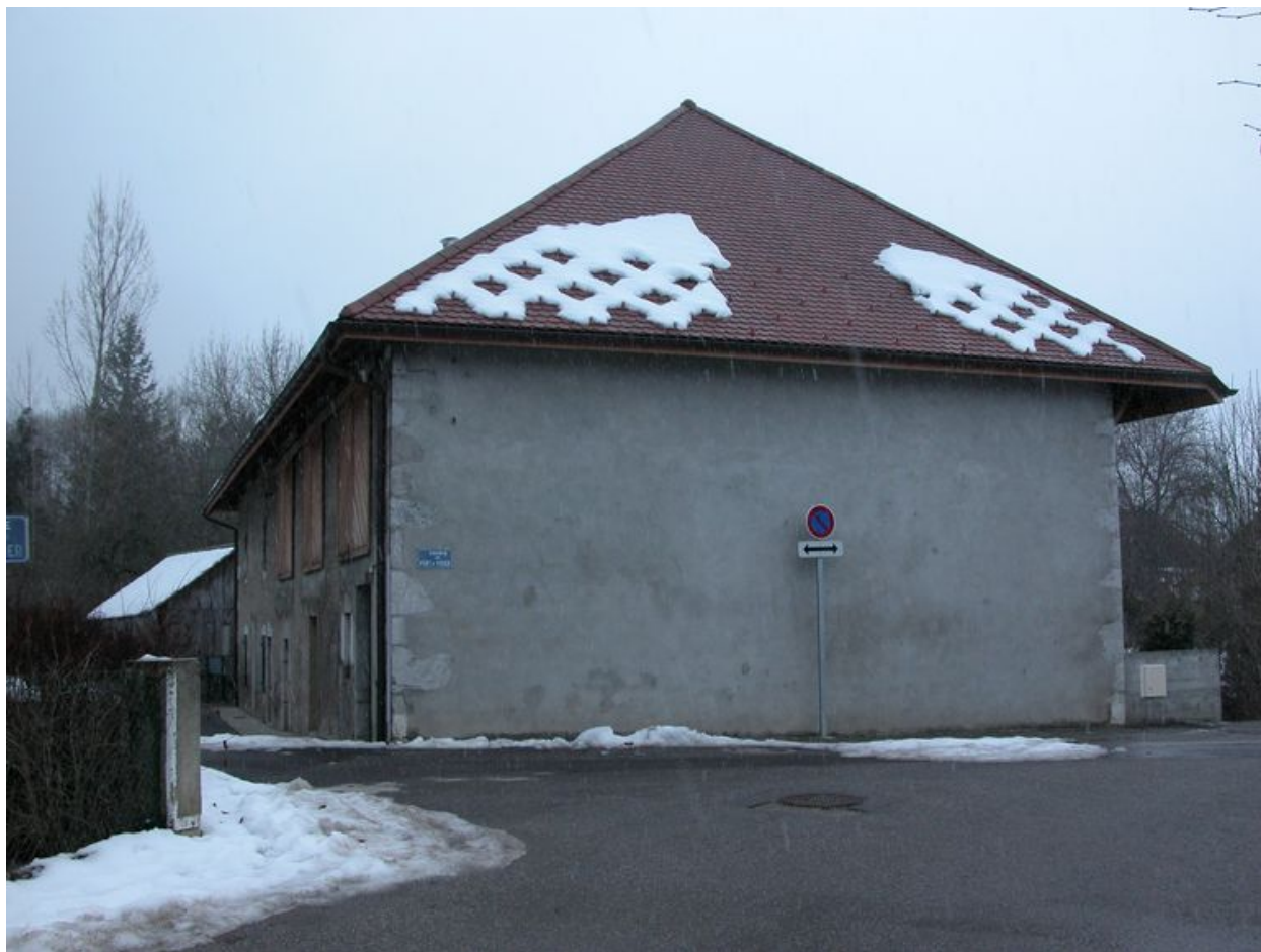
Vue du pignon nord.
