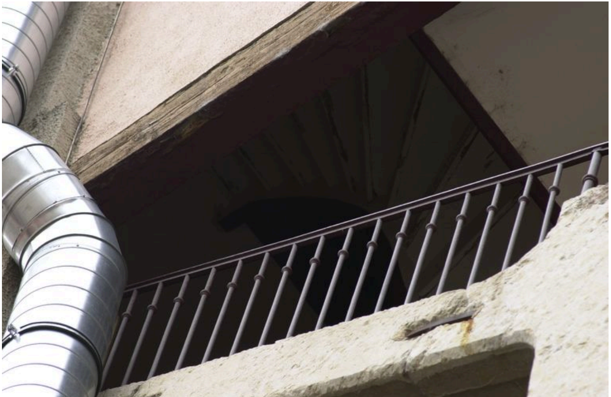
Vue du dernier étage de la cage d'escalier
