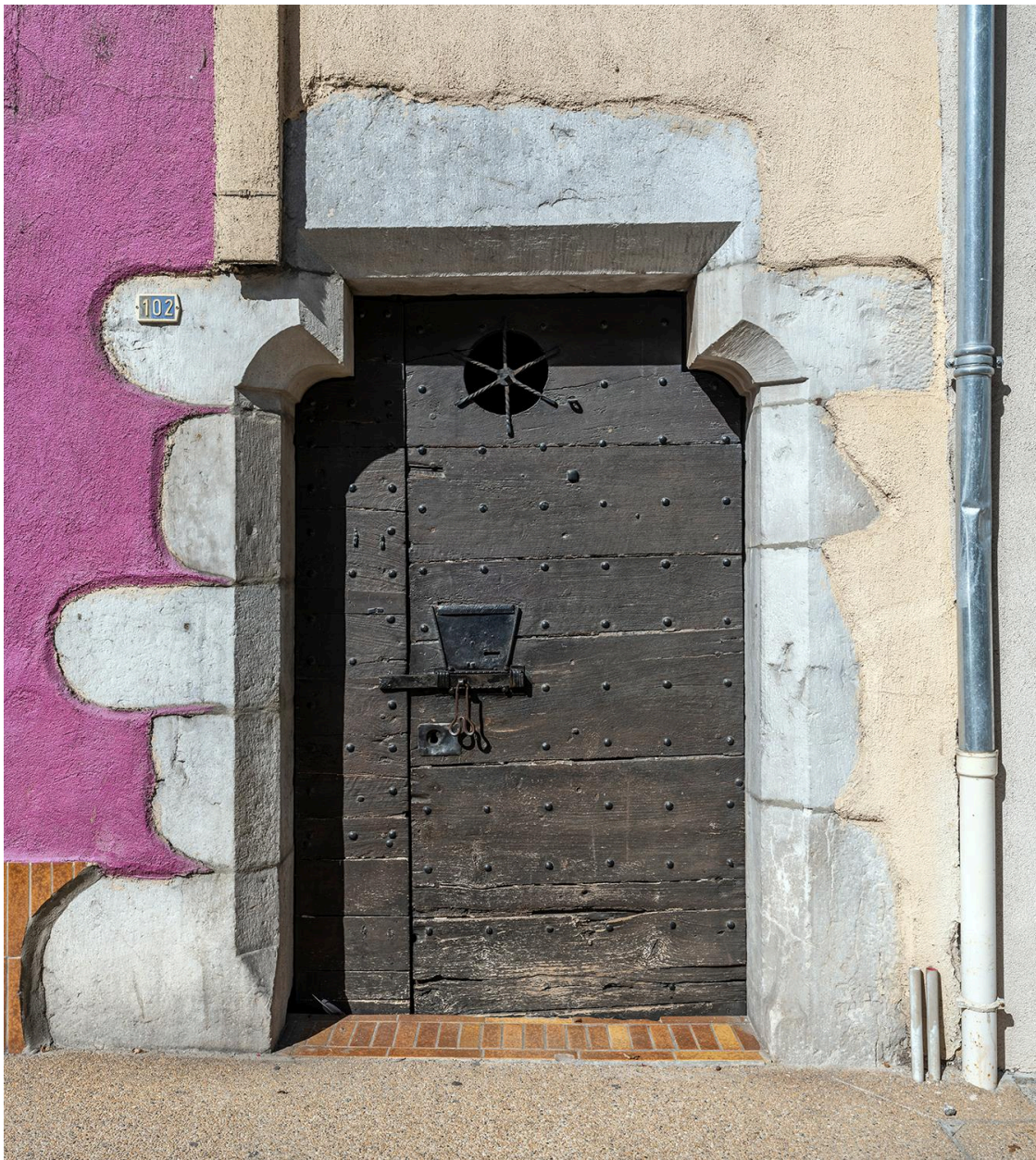
Encadrement de porte avec linteau sur coussinet rue Sadi Carnot (2008 D15 2376, 2377, 2379, 2825, 4559).
