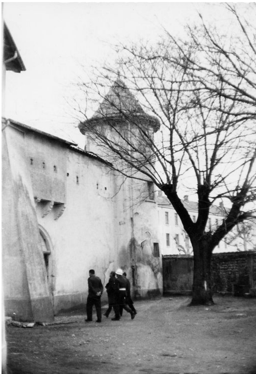
Elévation est. Vue prise en 1970
