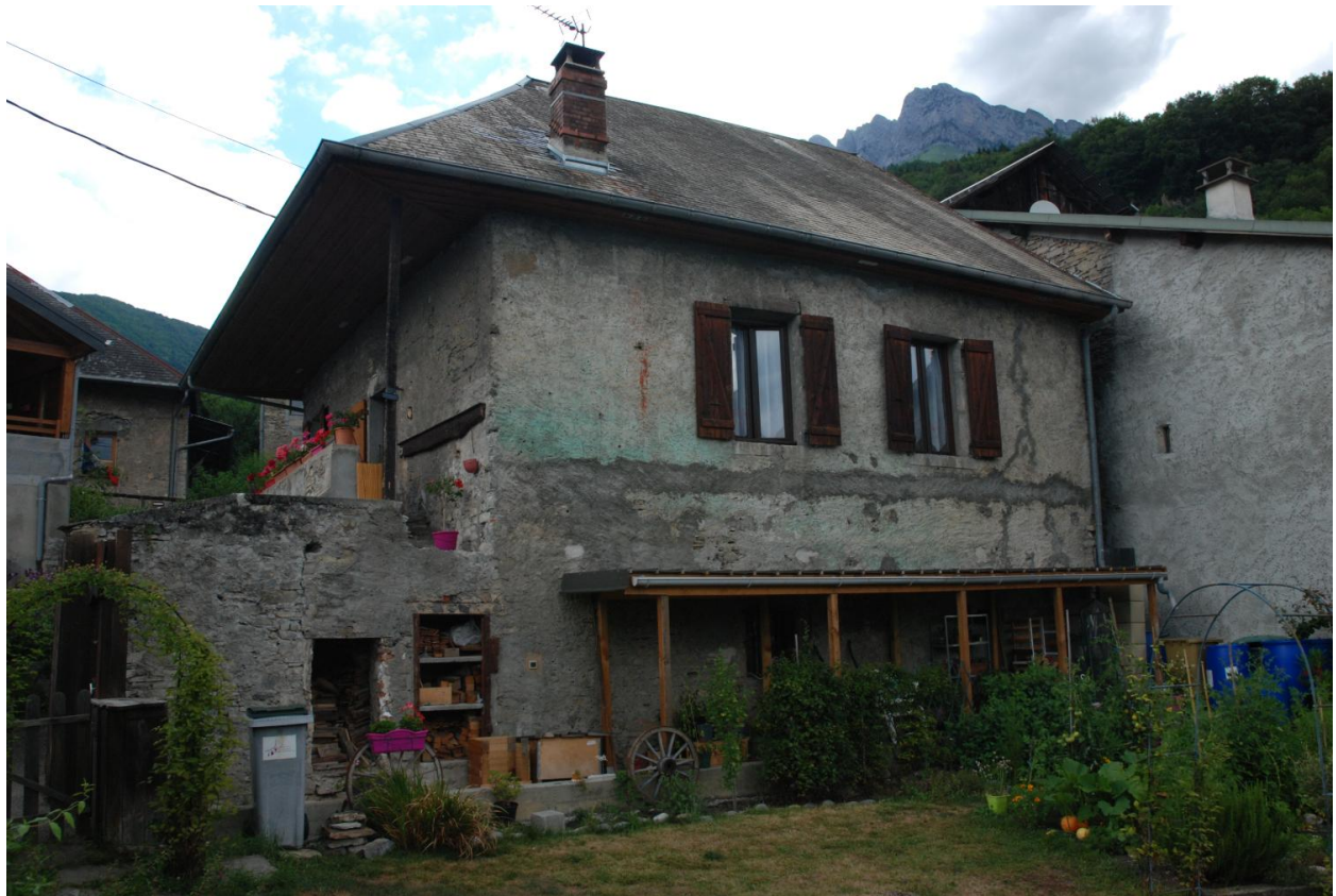
Maison de vigneron (2018 E3 758, 761). Vue sud-ouest.
