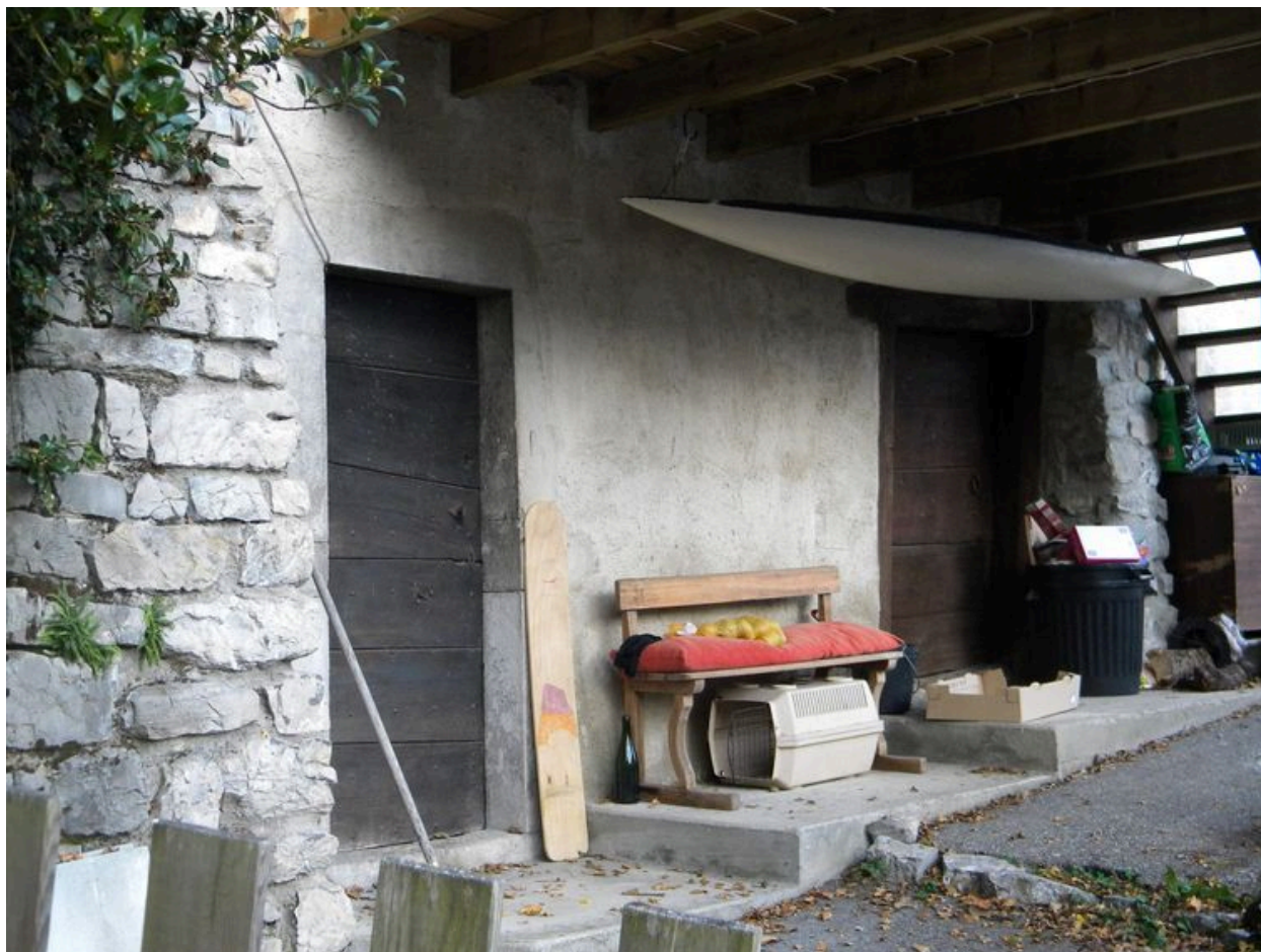
Vue d'ouverture avec des encadrements en pierre de taille sur un ancien cellier transformé en habitation. (2008 A8 1864)
