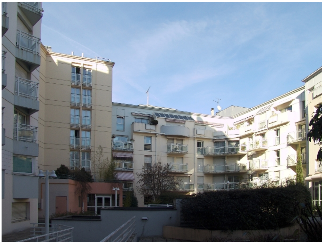
Façades sur cour
