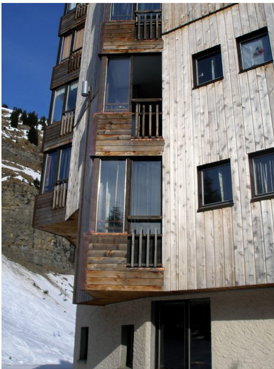
Détail des balcons, façade nord
