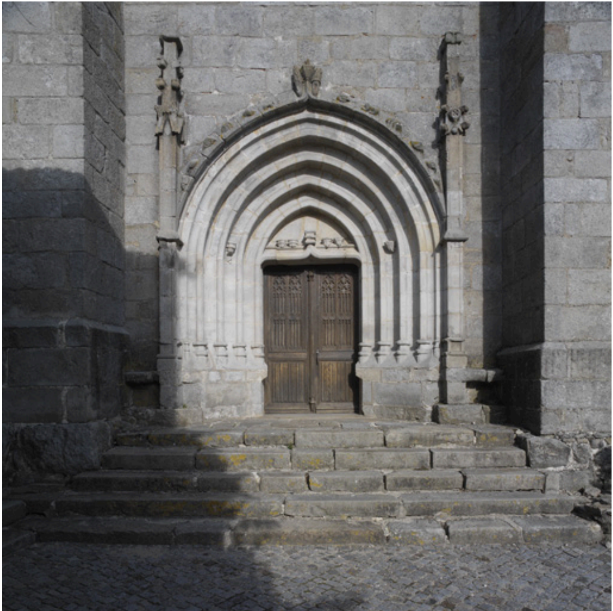
Vue d'ensemble du porche de l'église.
