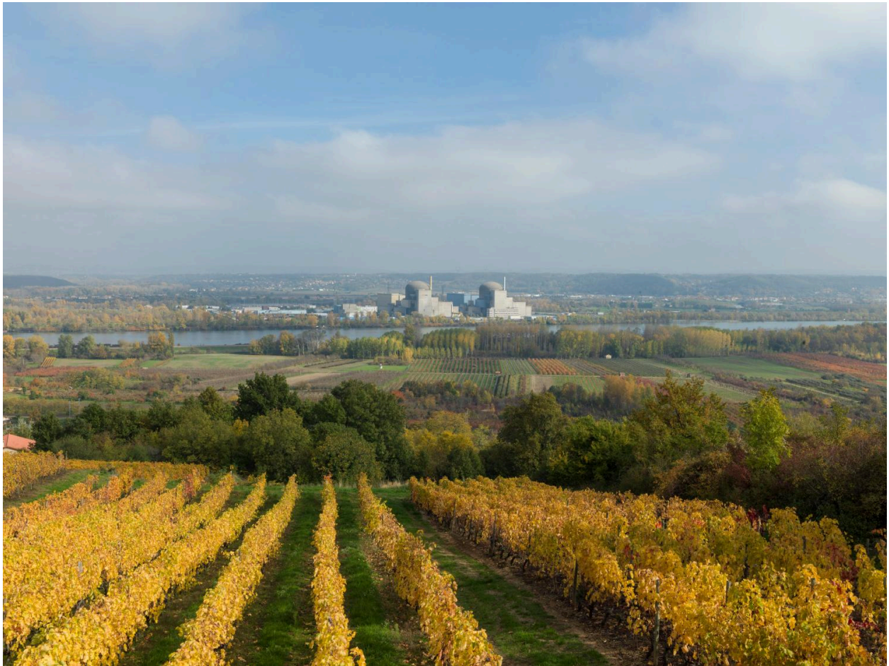
Vue de la centrale dans le grand paysage de la vigne
