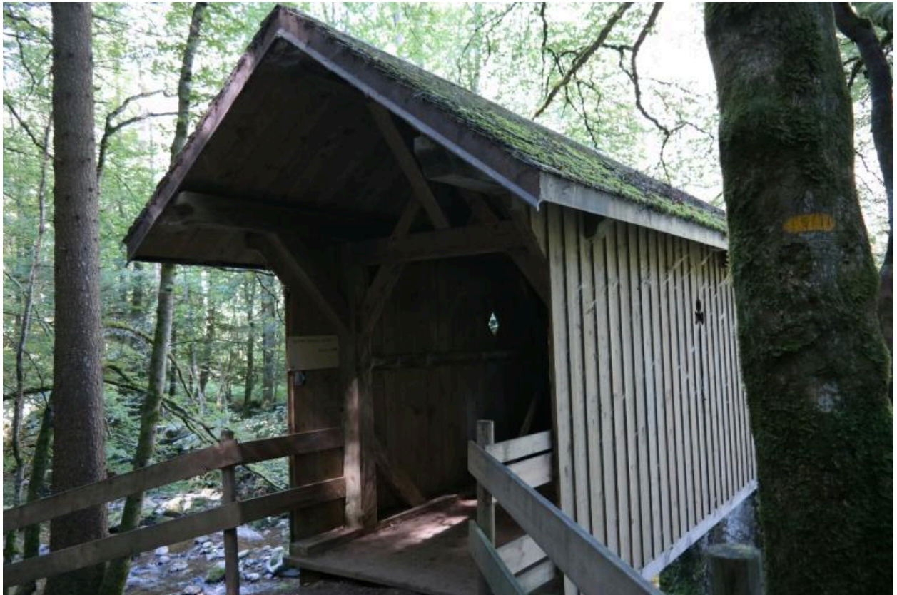
Pont couvert de Bellevaux, vue depuis la rive droite
