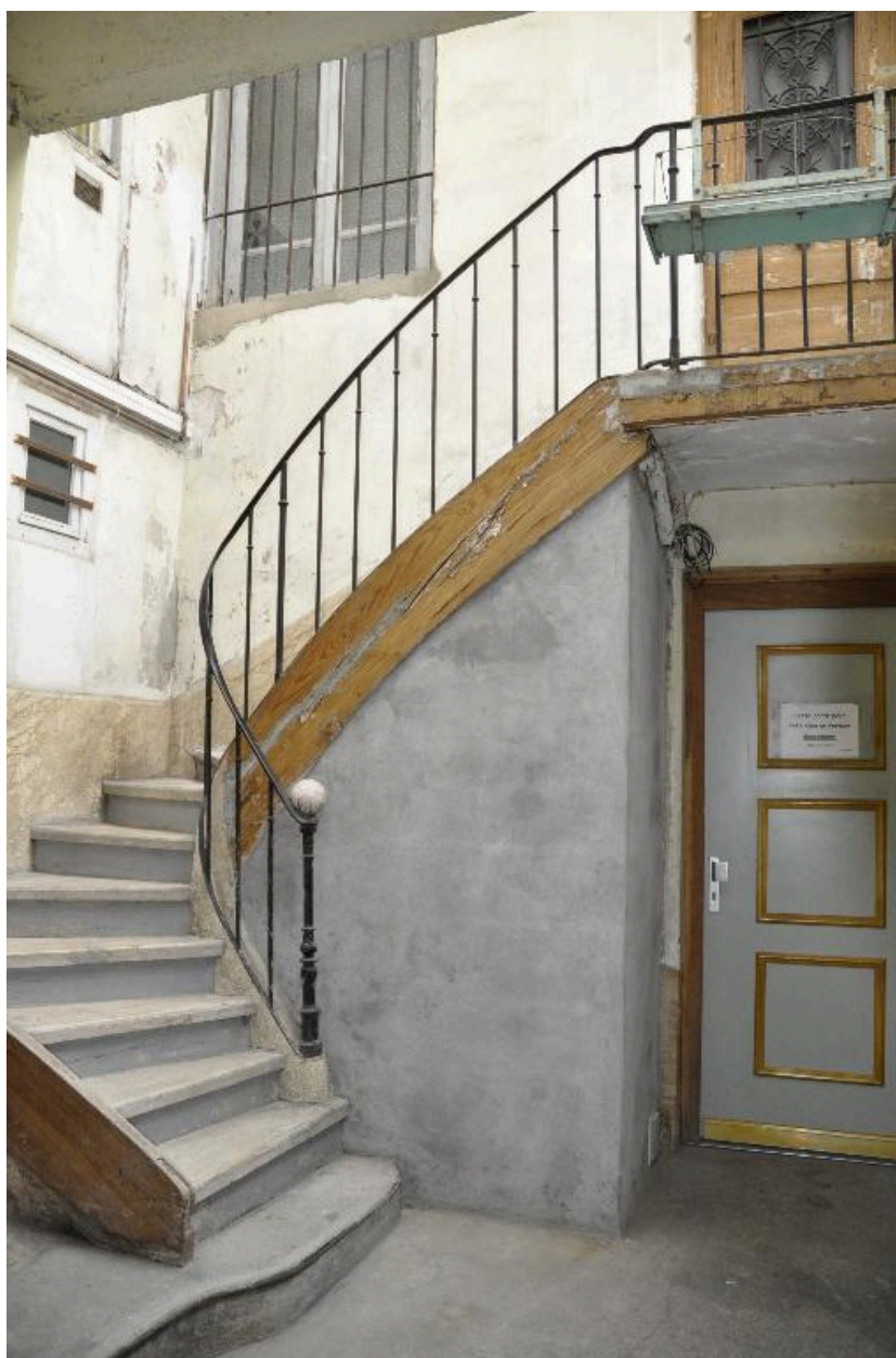
Vue de l'escalier du troisième corps de logis
