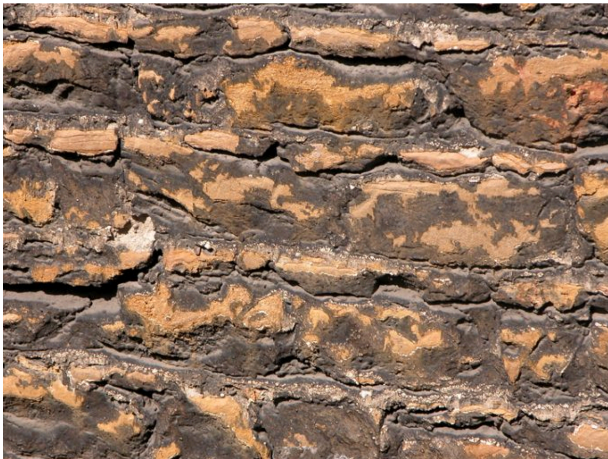
Détail des matériaux, corps de bâtiment oriental
