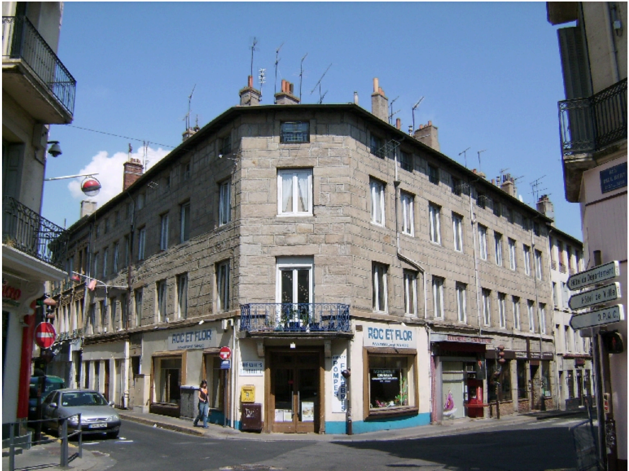
Vue d'ensemble ; à gauche la rue Jules-Ledin
